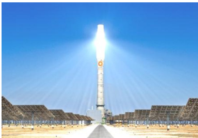
Рисунок 40 - Башенная солнечная электростанция
