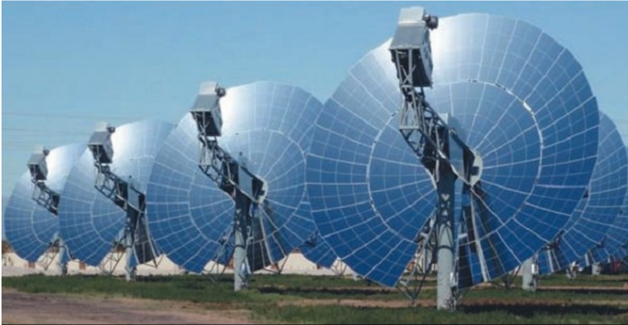
Солнечная электростанция мощностью 1,5 МВт [округ Марикоп, Аризона (США)] с двигателями Стирлинга
