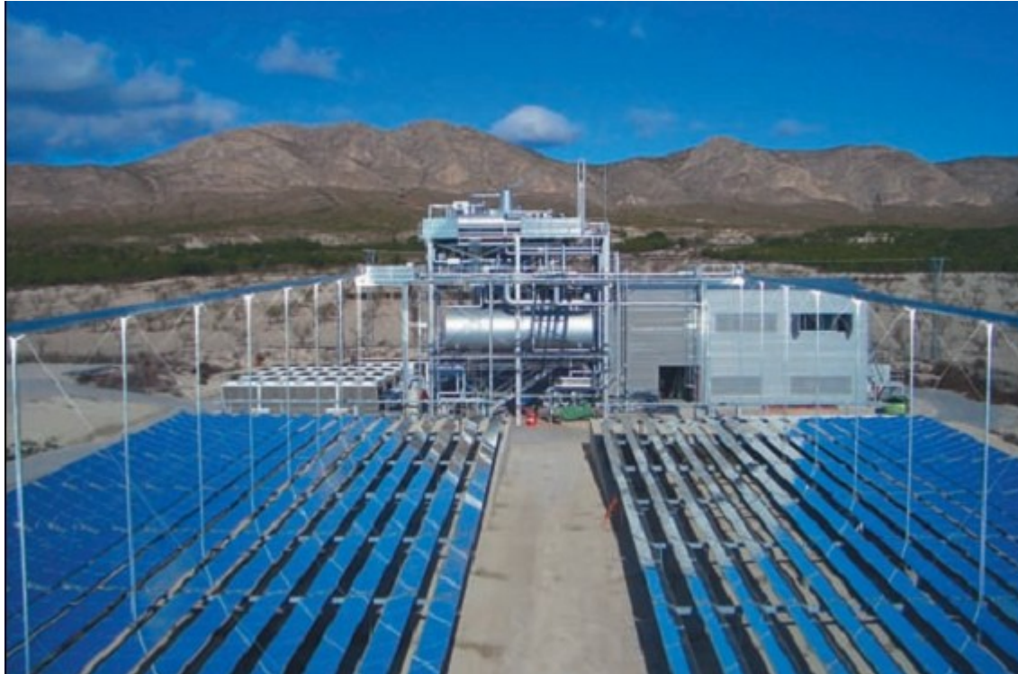
Демонстрационная солнечная тепловая электростанция мощностью 1,4 МВт (Испания) с линейными концентраторами Френеля [разработчик Novatec Solar (Германия)]
