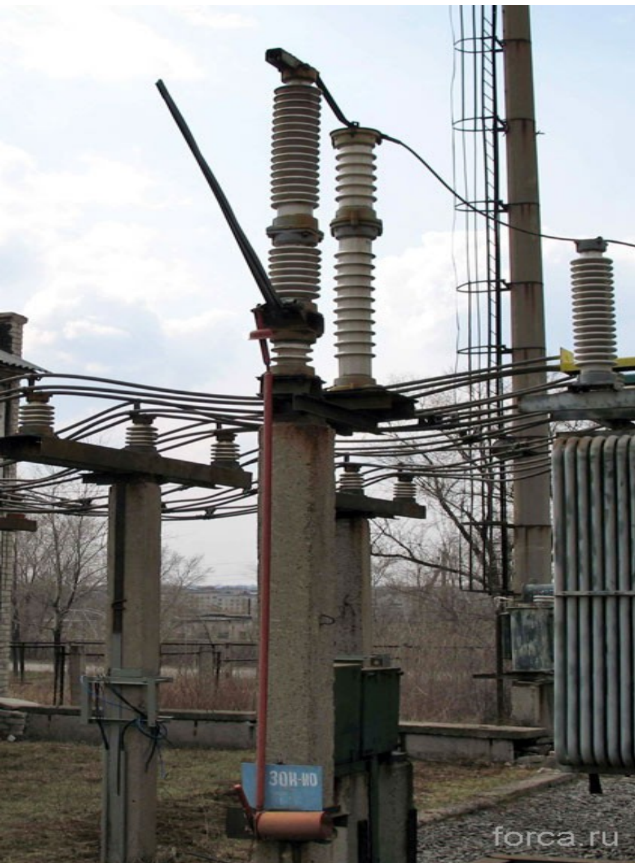
Заземлитель типа ЗОН-110
