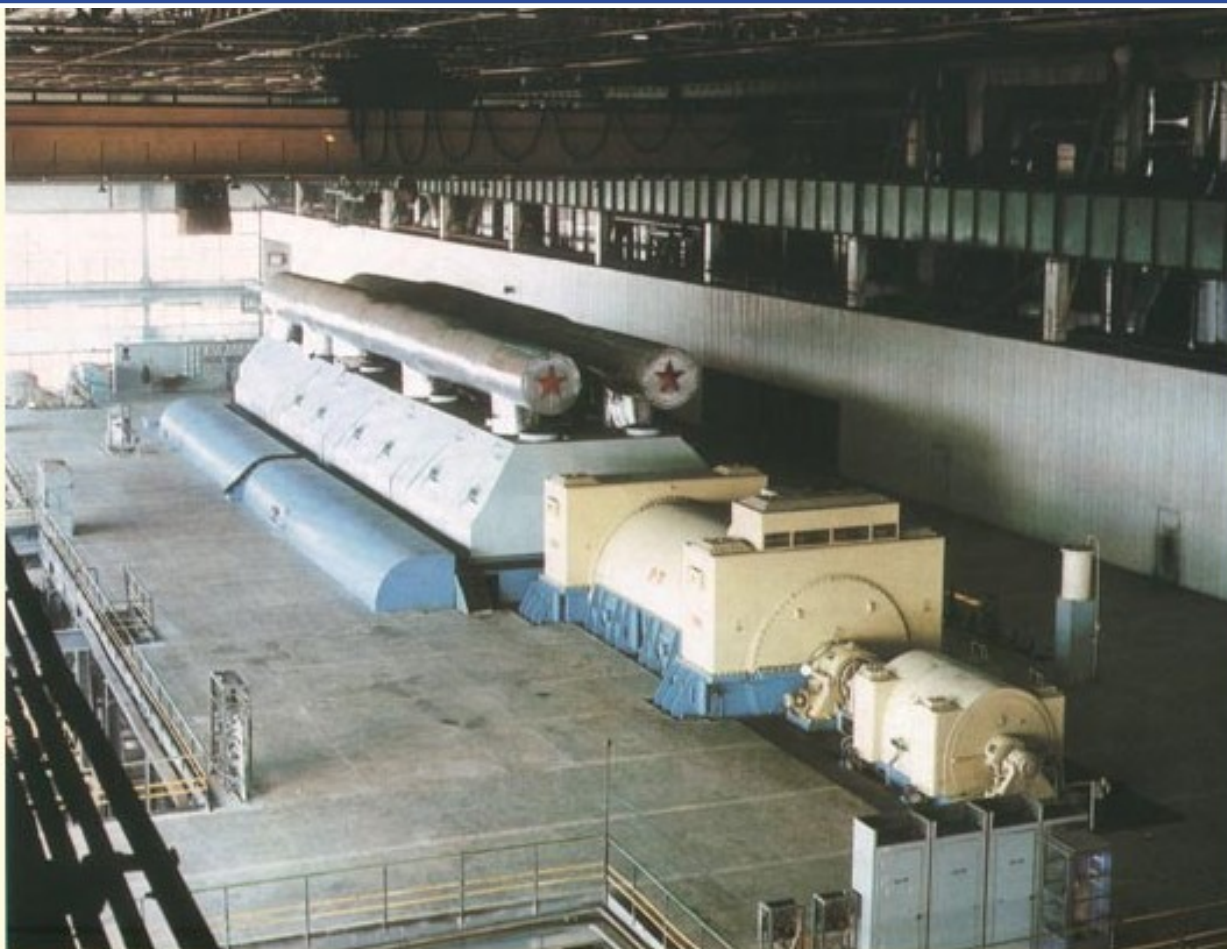
Рис. 2.8. Общий вид турбины мощностью 800 МВт, установленной в машзале ТЭС
