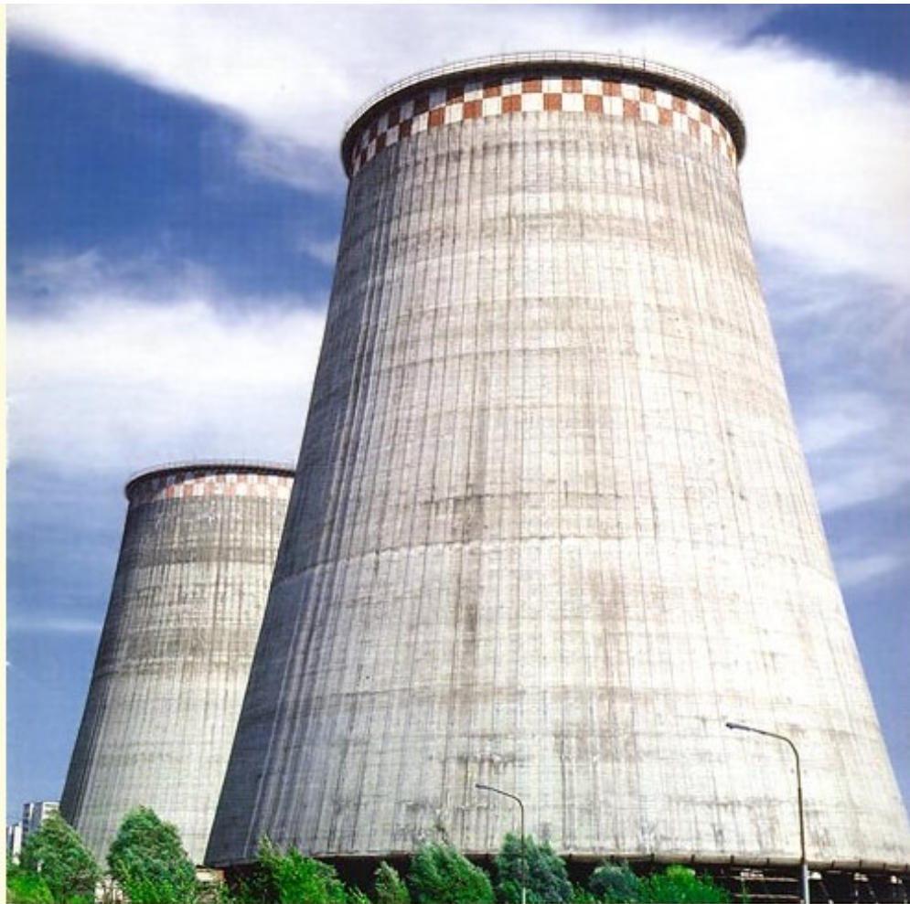
Рис. 2.4. Внешний вид башенной градирни
