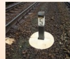
Рис. Закрепление пикета и плюса: 1 – кол; 2 – сторожок
