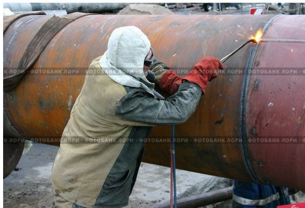
Газовая сварка © Александр / Фотобанк Лори
