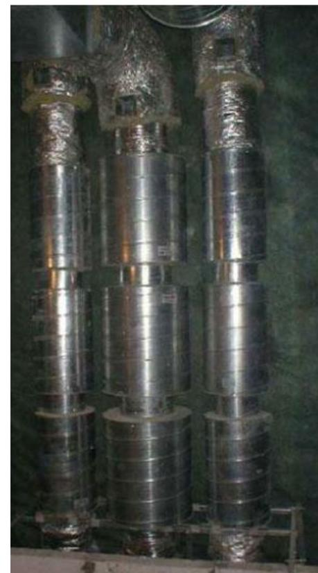
Акустические фильтры, установленные в системе приточно-вытяжной вентиляции и воздухообмена
