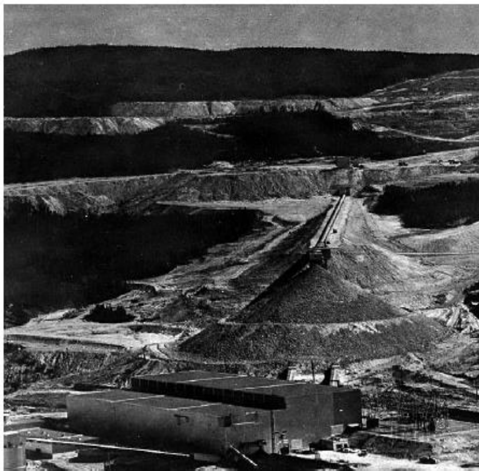
Рис. 8.7. Схема и общий вид напольного открытого склада с одноточечной загрузкой
