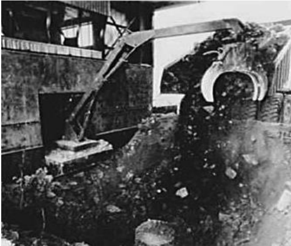
Рис. 8.1. Механический захват для негабаритных кусков руды перед дробилкой крупного дробления
