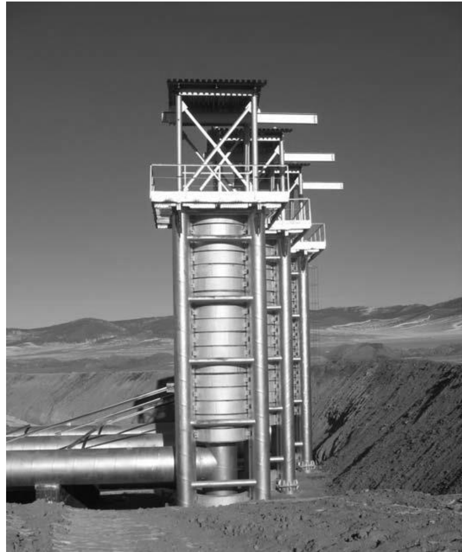
Рис. 14.9. Водоприемные колодцы с сифонными водозаборами
