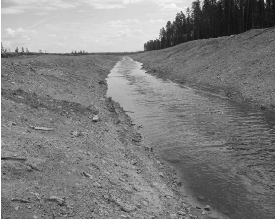
Рис. 14.8. Дренажная водоотводная канава
