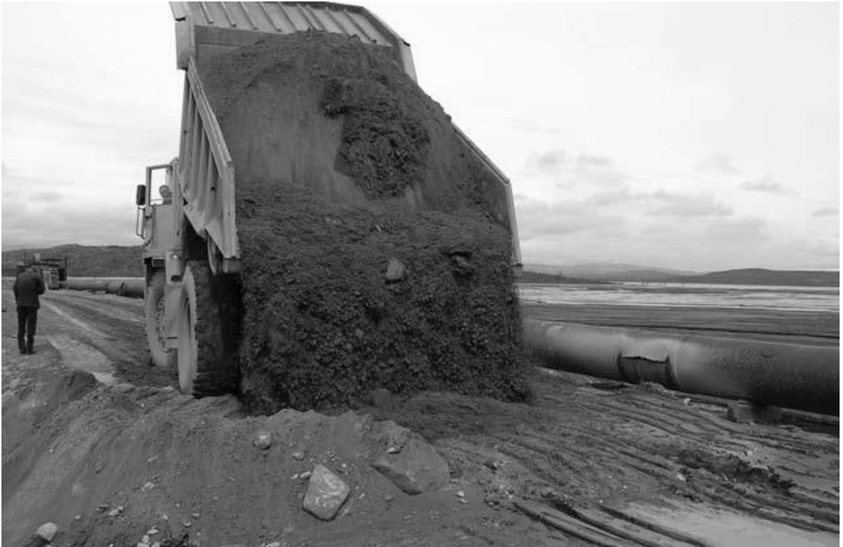
Рис. 14.7. Нарращивание дамбы вторичного обвалования
